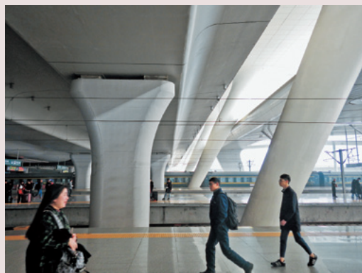
【写真2】杭州東駅のプラットフォーム 中国の新幹線の停車駅はどれも巨大で圧倒された。
