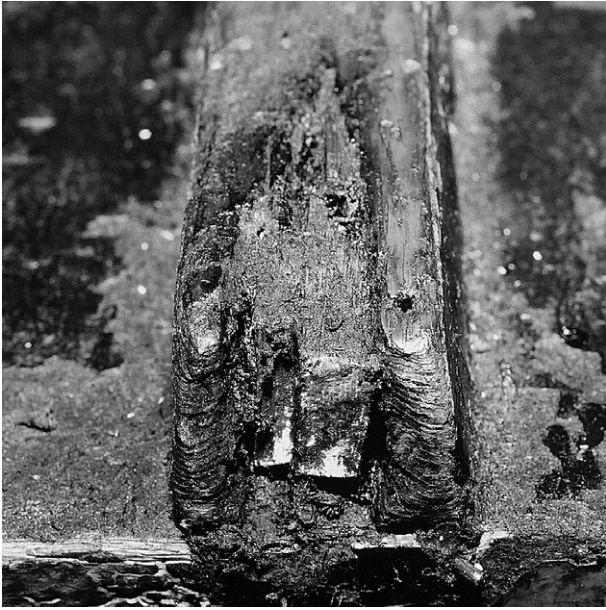
图6 外箱 底面 栈脚 修理中
