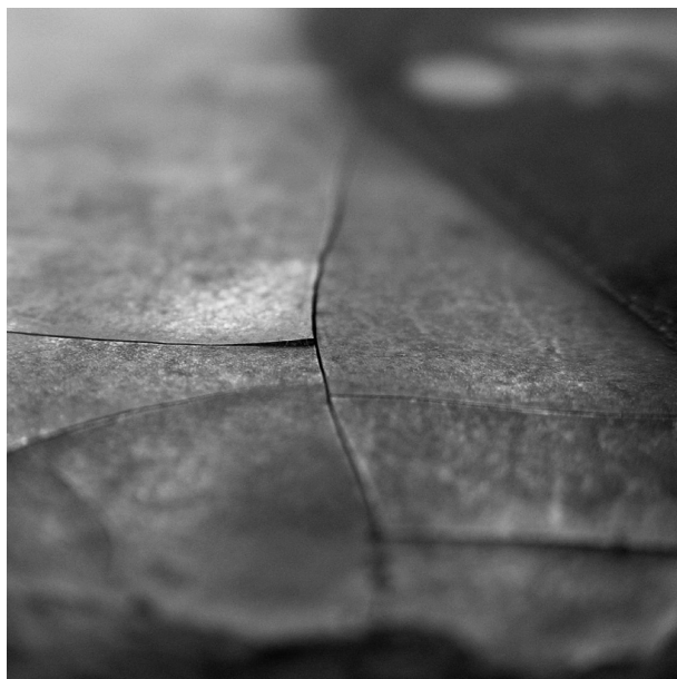
図9 支持体からの浮き上がり 修理前
